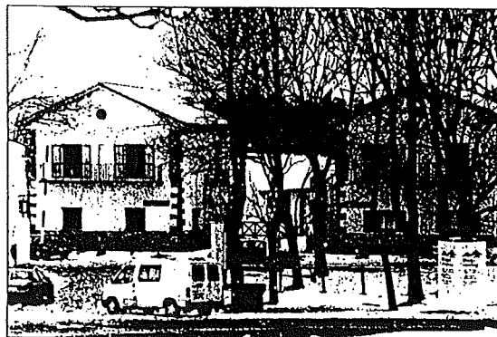
Las naves contienen el albergue, el restaurante y los distintos servicios.
